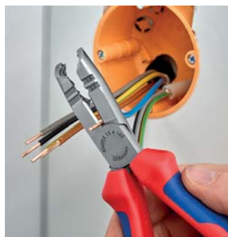
Řezání při zkracování jednotlivých vodičů
